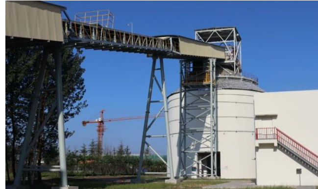
华能日照电厂耦合生物质发电项目 Rizhao Project in Shandong
