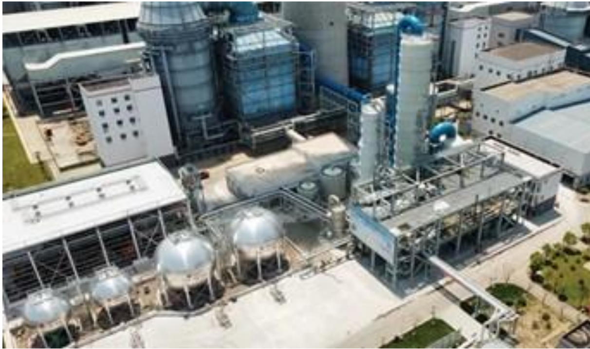
江苏省泰州燃煤电厂的年产50万吨碳捕集设施
